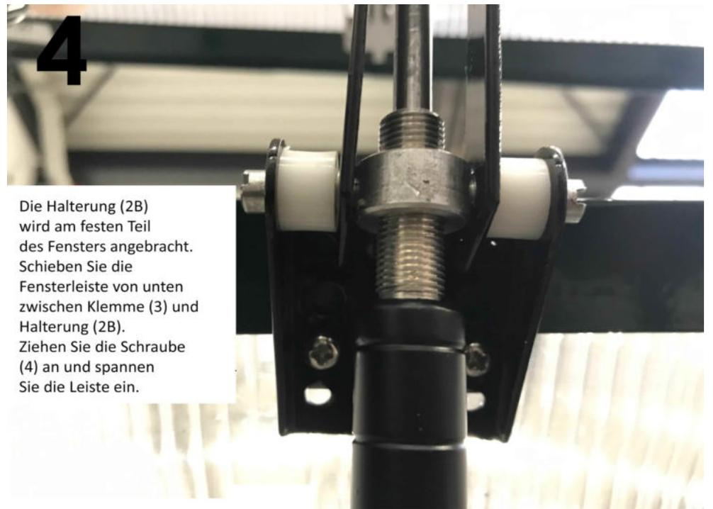
Die Halterung (2B) wird am festen Teil des Fensters angebracht. Schieben Sie die Fensterleiste von unten zwischen Klemme (3) und Halterung (2B). Ziehen Sie die Schraube (4) an und spannen Sie die Leiste ein.
